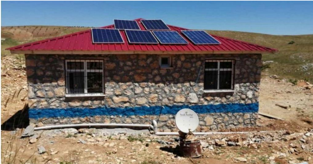
Şekil 6: Güneş enerji sistemi ile donatılmış taş ev, su ve kanalizasyon tesisatı, zararlılara karşı bariyer amaçlı uygulanmış mavi boya ve arka planda ise sıralı dikilmiş fidanlar görülmektedir.
